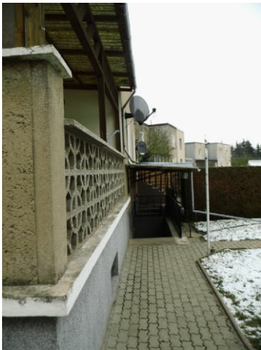
Weg zum Kellerabgang
